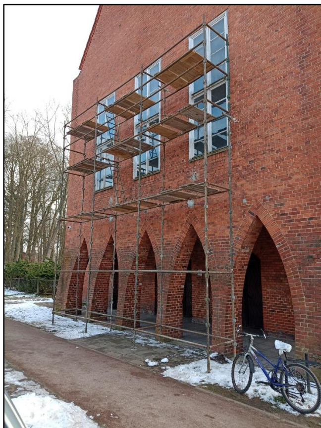
Wymiana okien na scenie –sala widowiskowo -kinowa
