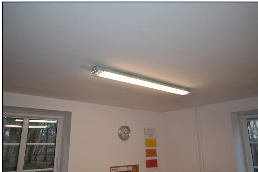
Wymiana oświetlenia w biurach na energooszczędne typu LED
