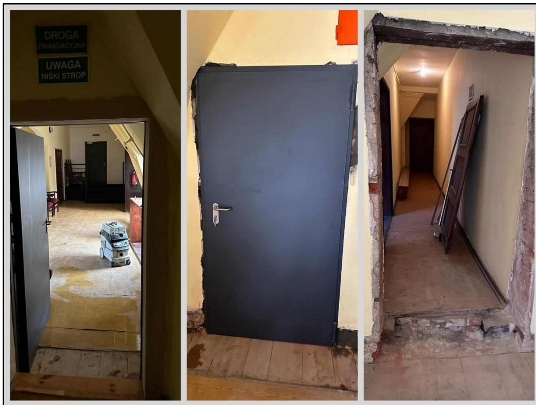
Montaż drzwi przeciwpożarowych – hol II piętro
