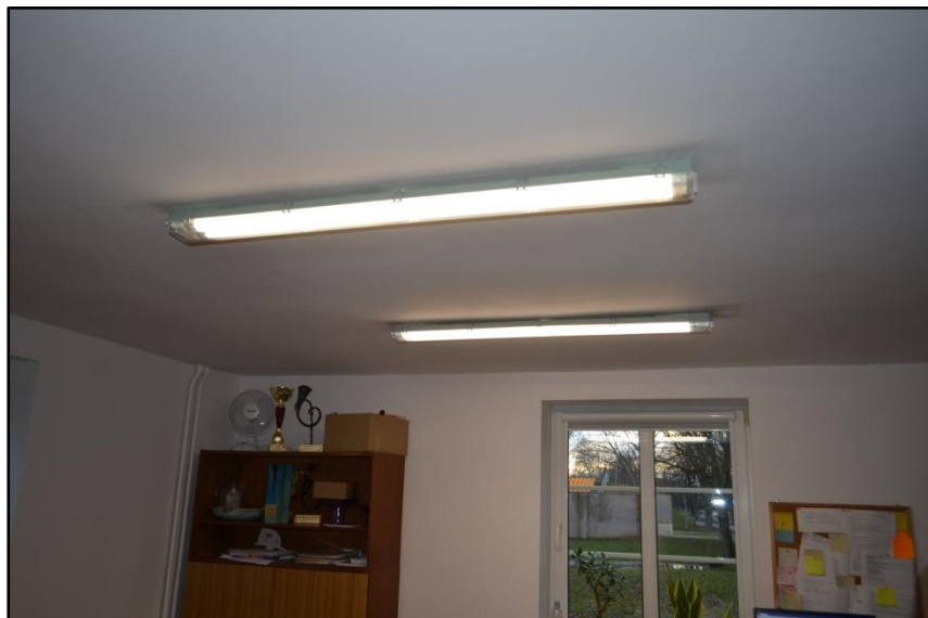
Wymiana oświetlenia w biurach na energooszczędne typu LED
