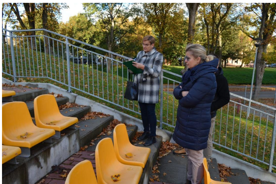
Przeгляд gwarancyjny: „ Przebudowa proscenium i widowni amfiteatru ”
