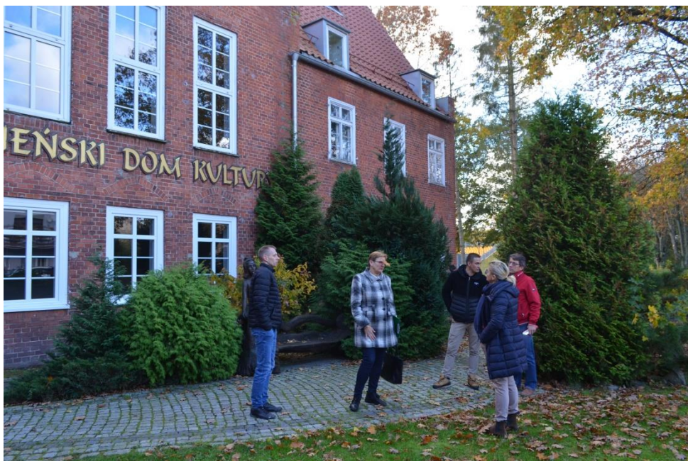
Przeгляд gwarancyjny: „Remont pokrycia dachowego w Sławieńskim Domu Kultury”
