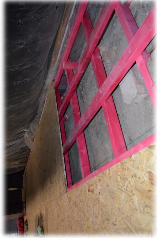
Nowa konstrukcja została wykonana z drewna impregnowanego przeciwpożarowo...
