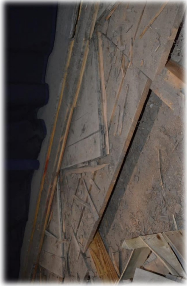
Podłoga składała się z 4 warstw: desek oraz parkietu położonych przed wojną i dwóch warstw desek położonych w czasach PRL.
