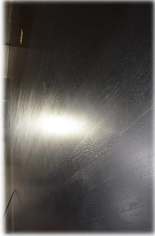
Całość pomalowano na czarno w celu zapewnienia jak najlepszego wyglądu końcowego, jak i zapobiegnięcia podświetlania ekranu kinowego światłem odbitym.
